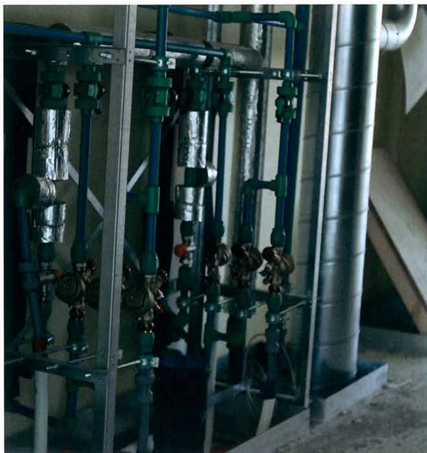
△ Bouw van een hotel, decentrale installatieskids per verdieping.
